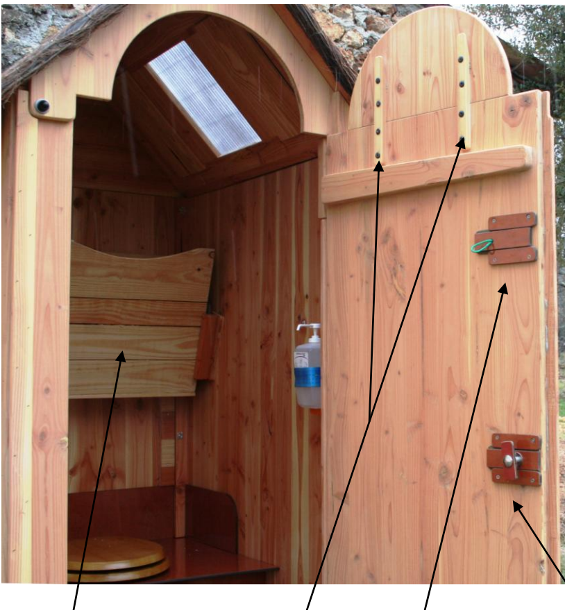
Réservoir à copeaux – portes manteaux – verrou intérieur – fermeture extérieure - déplaçable avec transpalette
